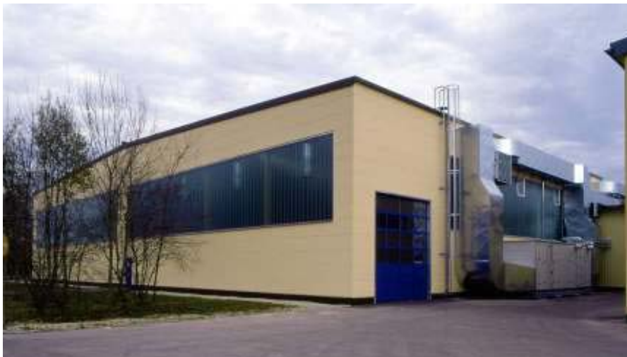
Salle 7.2 dans son état final, en novembre 2002.
